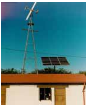
Solar PV modules
